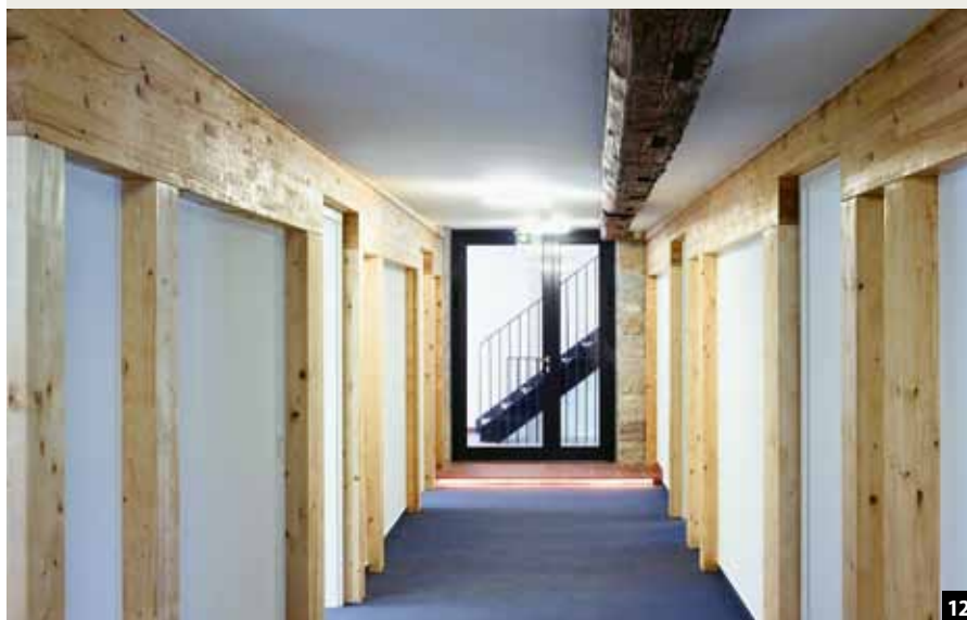
Abb. 12: Die komplette Konstruktion aus Brettschichtholzbindern ist frei sichtbar geblieben.
