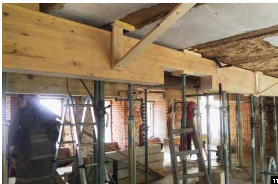
Abb. 11: Bei der Holzbalkendecke über dem Erdgeschoss wurde die tragende alte Mittelachse aufgelöst und durch zwei Achsen als Flurbegrenzung ersetzt. In die neuen Achsen wurden Brettschichtholzbinden gelegt.
