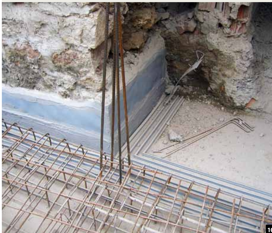
Abb. 9/10: Eine ganz besondere Herausforderung war die Planung und Ausführung der Bauwerksfuge innerhalb der weißen Wanne zwischen dem alten und dem neuen Gebäude.
